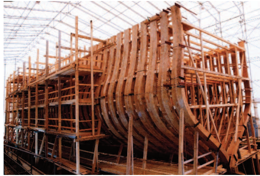
1 - Une structure massive en poutres de chêne et une double peau de forte épaisseur sont assemblées à partir de 1997.
