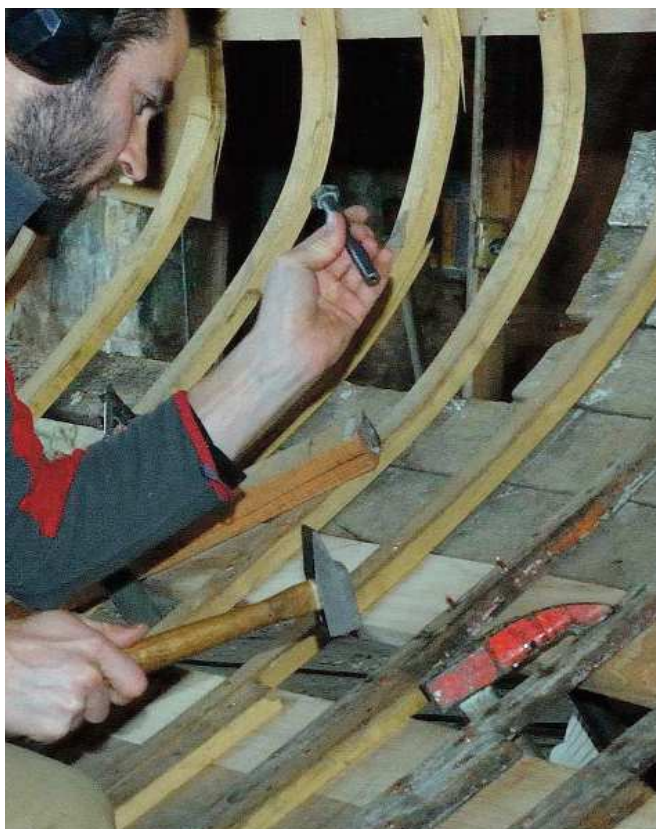
La construction et la remise en état des bateaux en bois reste le cœur de l'activité des chantiers Tramasset
